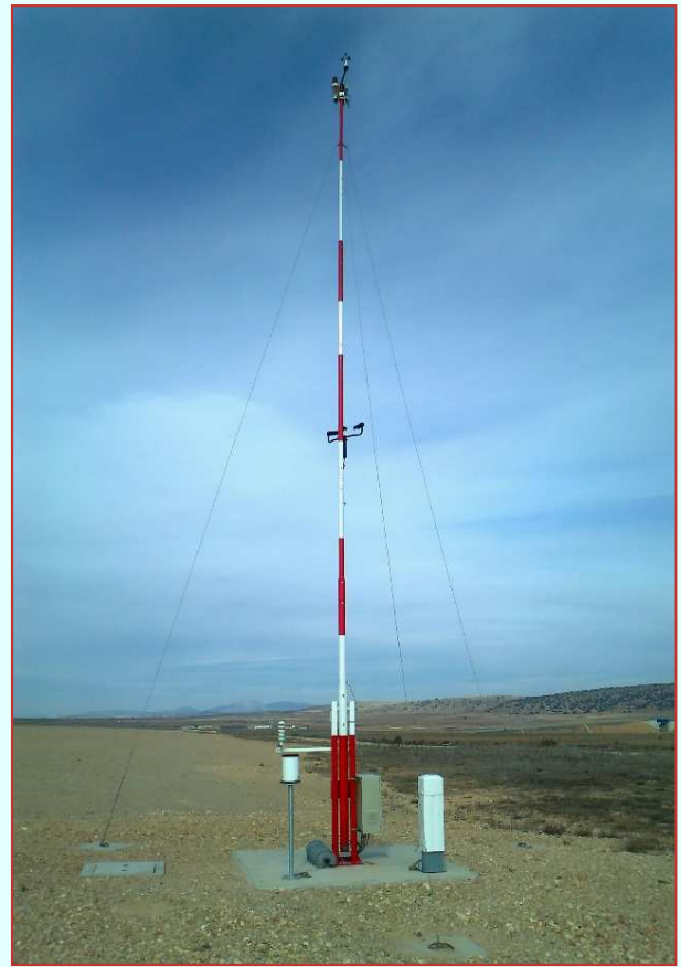
Estación meteorológica automática
